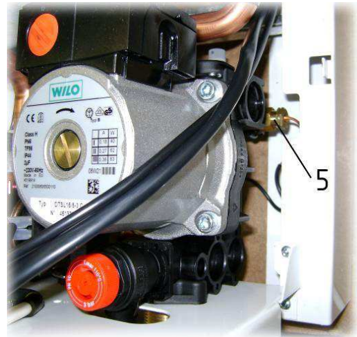
Рис. 25. Демонтаж насоса
