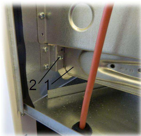
Рис. 20. Демонтаж блока горелочного
